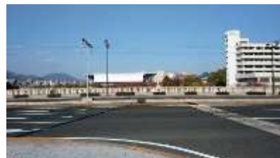
相生橋越えの遠景
