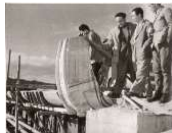
西平和大橋の工事現場のチェックをしているイサム・ノグチと丹下健三
