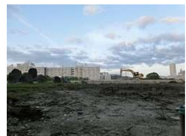
中央公園西側エリア 作業風景
